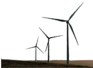
utiliza a força dos ventos para gerar eletricidade. As pás do aerogerador são movidas pelo vento, e seu movimento aciona um gerador que converte a energia cinética do vento em energia elétrica.
